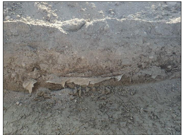
Modernin rakennuksen perustusta koejassa 4.
